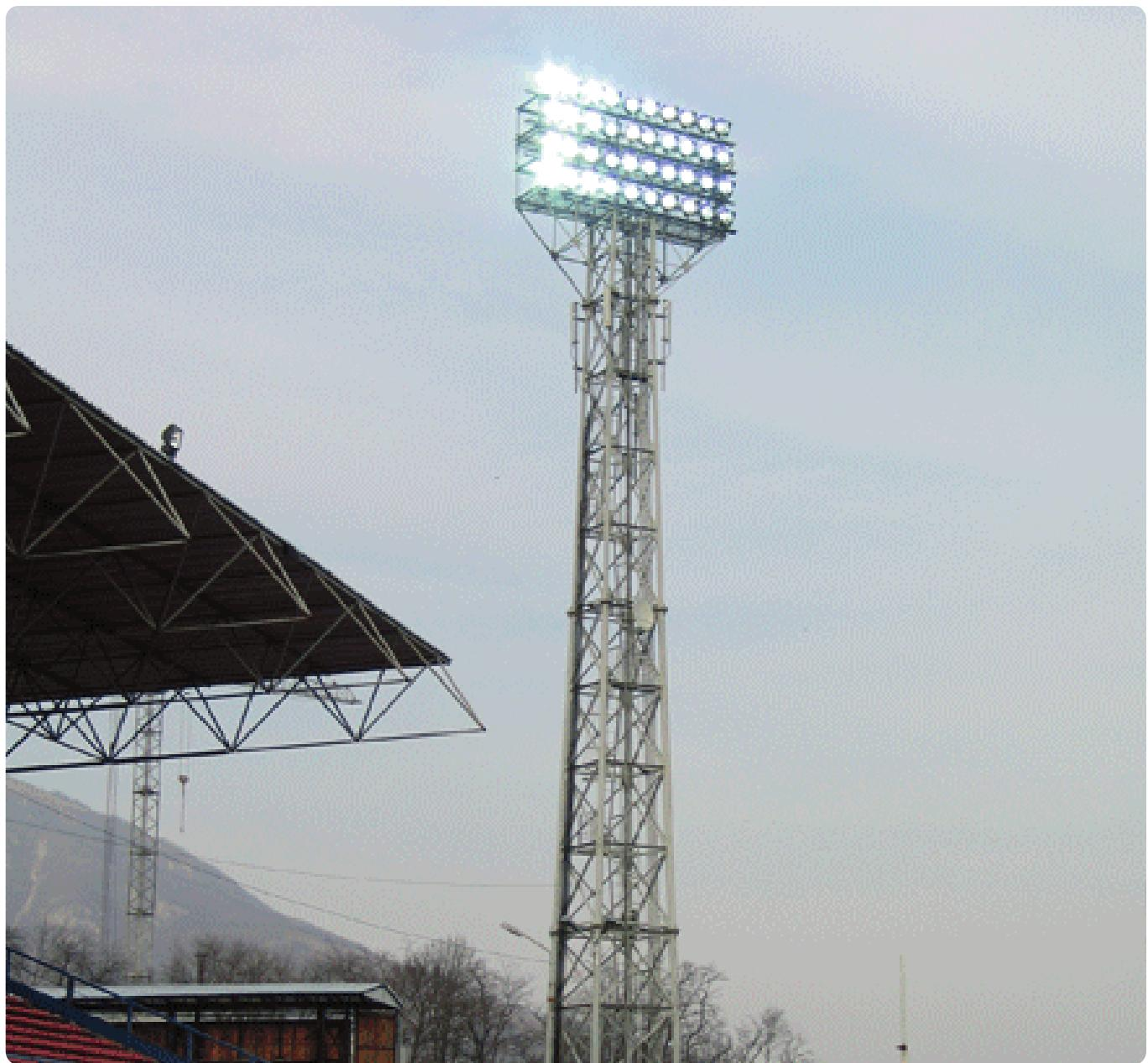
**Мачты освещения - МО** могут комплектоваться съемными и несъемными коронками. Съемные коронки обслуживаются через люк с земли, а для обслуживания вторых применяются грузоподъемники и специальные лестницы с ограждениями. Смотря на то, какой объект необходимо осветить, устанавливают столб разной высоты: как правило, высота варьируется в широком диапазоне, и можно монтировать как трехметровую стойку, так и сорок метровый столб.
